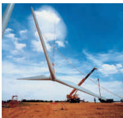
Abb. 3: Montage der Anlage mit zwei Kränen. Zu einem geeigneten Standort gehört unter anderem, dass er mit schweren und langen Transportfahrzeugen zugänglich ist (Foto: Bundesverband Windenergie, Deutschland)
