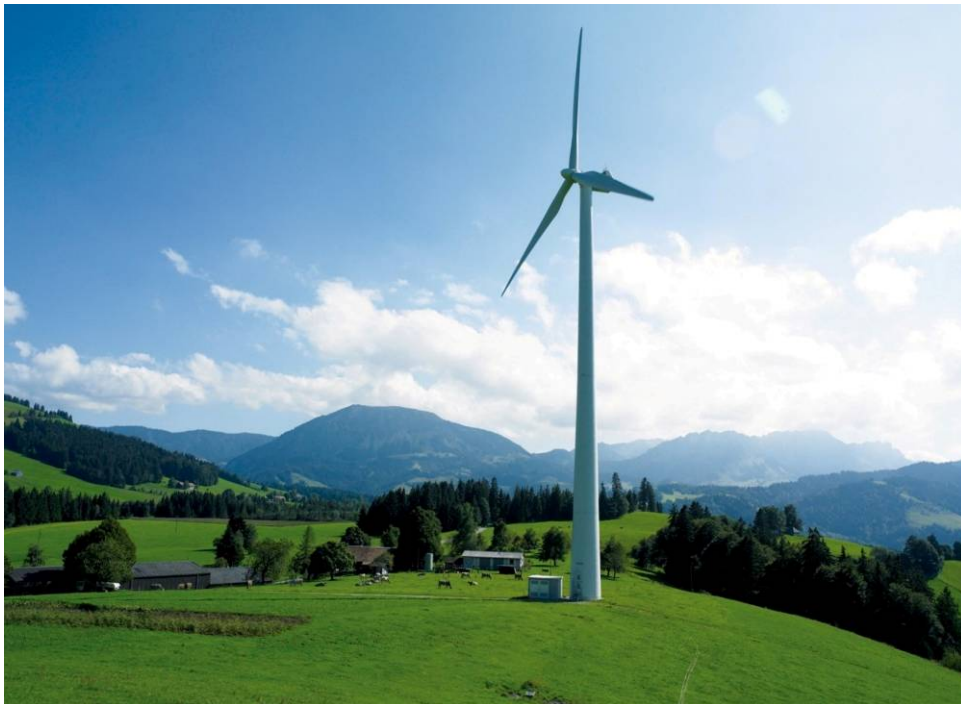
Windenergieanlage Feldmoos, Entlebuch (© www.erlebnisenergie.ch )
